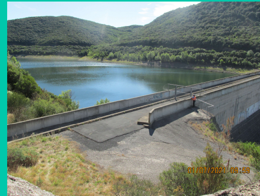
Barrage des Olivettes
