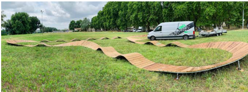
Aménagement d'un pumptrack léger pour le vélo
